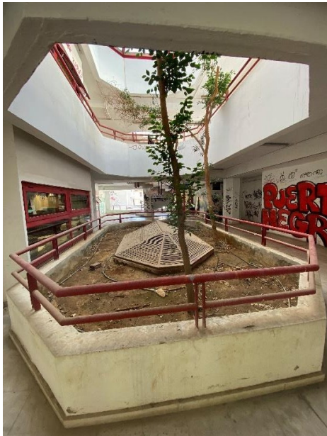
Εικόνα 1. Υφιστάμενη Κατασκευή στο μπαλκόνι της Τεχνικής Υπηρεσίας του Πανεπιστημίου Πειραιώς. Πηγή: Αυτοψία
